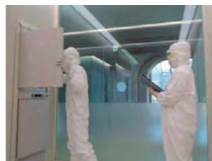
機能性液晶フィルム採用操作室壁ガラス (オン)
